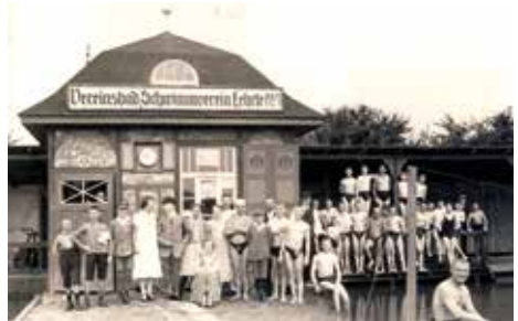
Lehrtes erstes Freibad wurde 1921 mit Hilfe des Schwimmvereins Lehrte (einem Vorläufer des Lehrter Sport-Vereins) in Eigenarbeit auf dem Schwanenburg-Gelände errichtet. Foto: Lehrter SV
